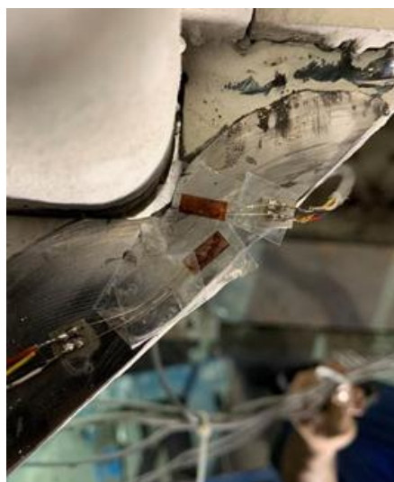
شکل ۹- کرنش سنجه‌های چسبیده‌شده روی دیافراگم خارجی در نمونه TSTBOD
