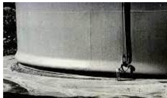
شکل ۱- کمناش پافیلی پوسته مخزن فولادی [۳]
