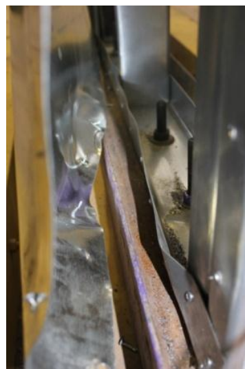
شکل ۴- بیرون آمدگی پیچ و جداشدگی پوشش از قاب پیرامونی شکل
