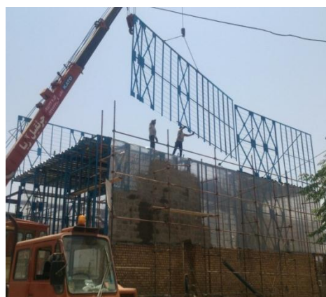
شکل ۶- اضافه نمودن طبقات بیشتر به ساختمان ساخته شده
