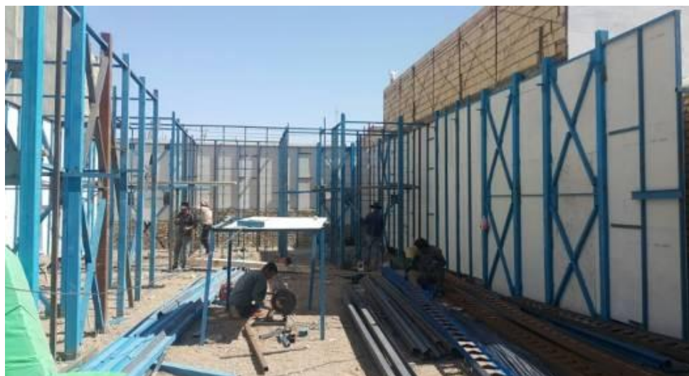
شکل ۴- اجرای دیوارهای خارجی
