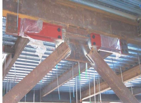
شکل ۴- میراگر اصطکاکی پال
