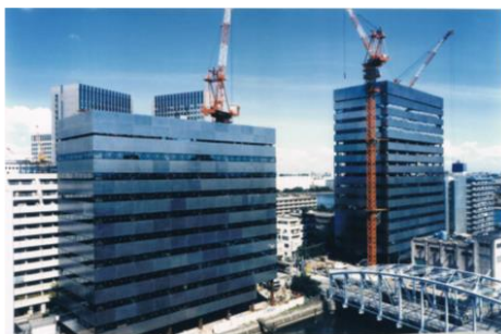
شکل ۲- اولین سازه‌های مجهز به مهاربند کمانش تاب، ساختمان دانشکده علوم کشاورزی دانشگاه کالیفرنیا دیویس آمریکا (۱۹۹۹) (شکل چپ) دفتر مرکزی شرکت نیپون استیل ژاپن (۱۹۸۷) (شکل راست)
