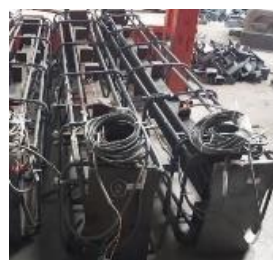
(پ) نصب کرنش سنج
