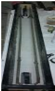
شکل ۲۱- قالب غلاف و آرماتورهای طولی و آرماتور صفحه انتهایی
